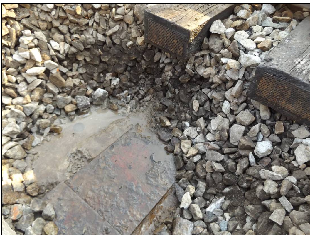
Obr. č. 11 - - detail krytu dilatační spáry v kopané sondě KS4
