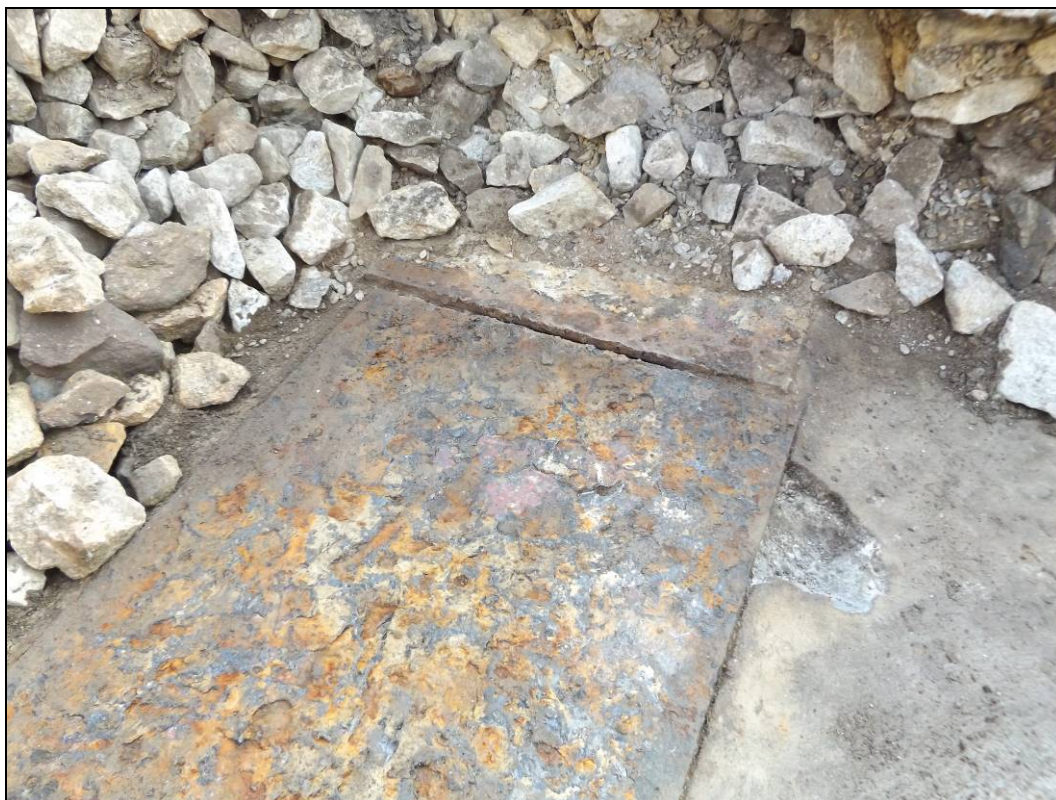
Obr. č. 9 - detail krytu dilatační spáry v kopané sondě KS3
