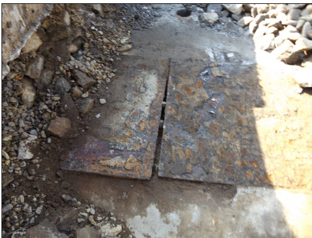
Obr. č. 6 - detail krytu dilatační spáry v kopané sondě KS1
